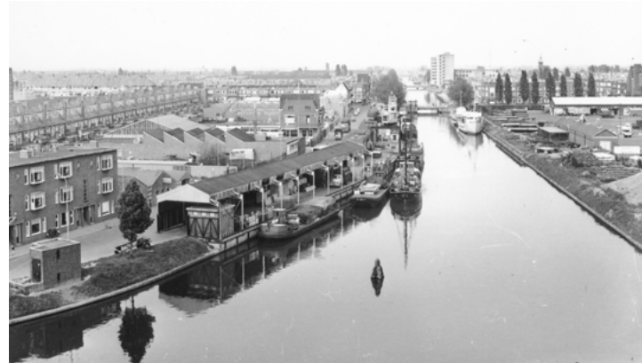
Oosterhamrikkade noordzijde in 1961 (foto: Piet Boonstra/Groninger Archieven)
