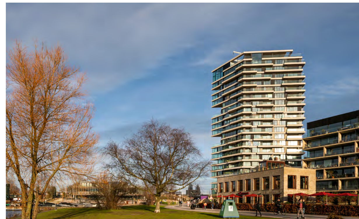
HAUT in Amsterdam is een hybride gebouw met houten draagconstructie (foto: Jannes Linders/Team V Architectuur)
